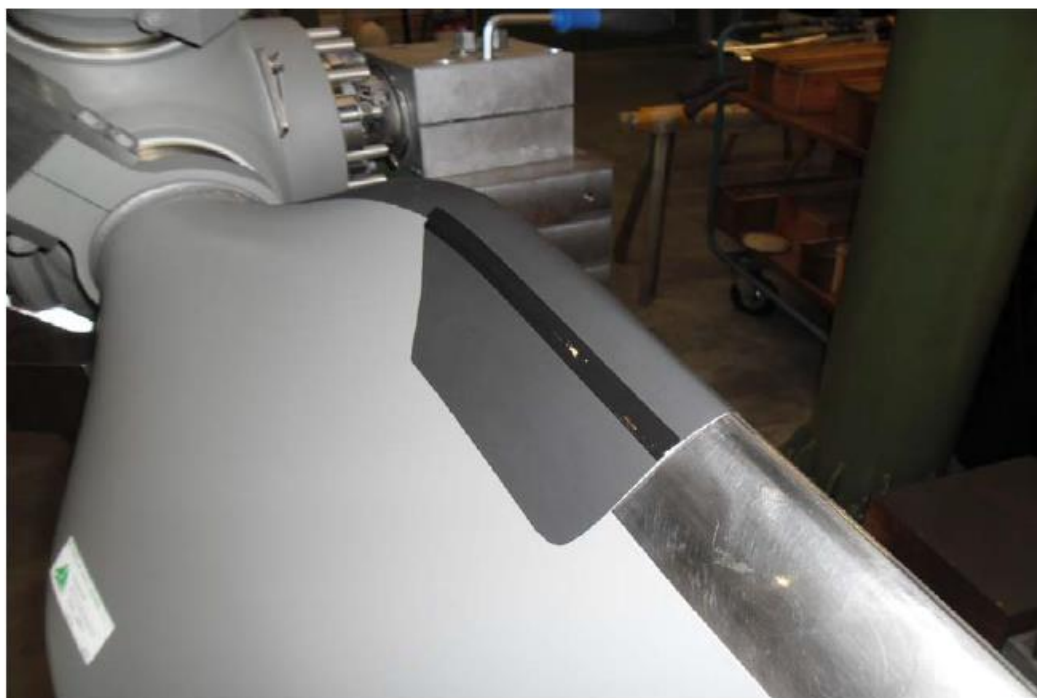
[7] Установленные заготовки защитной полиуретановой ленты
